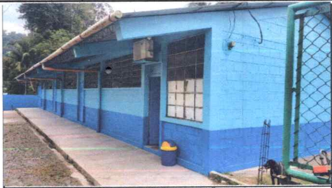
Foto 2: PINTURA PARA AULAS, COCINA Y BAÑOS EN INTERIOR Y EXTERIOR
