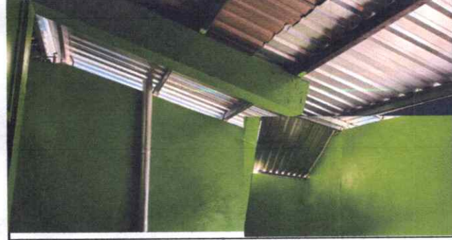
Foto 6: SUSTITUCION DE LAMINA DE LA COCINA
