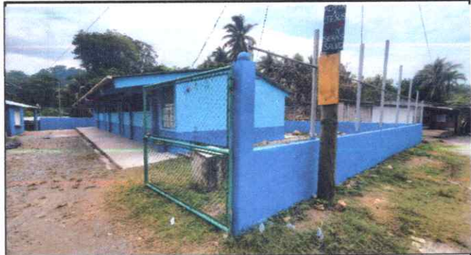
Foto 3: PINTURA DE MURO PERIMETRAL
