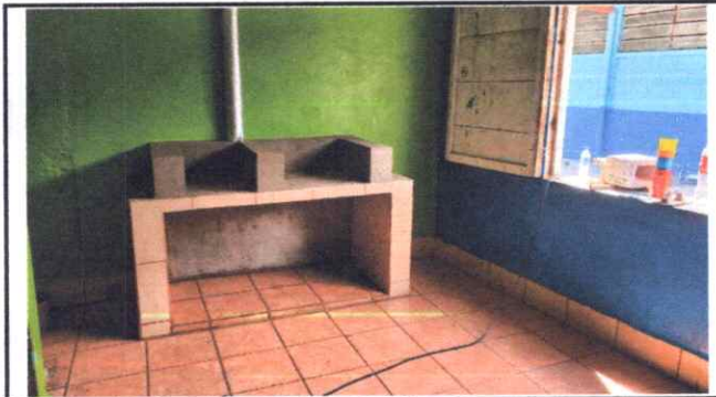
Foto1: SUSTITUCION DE PISO CERAMICO CHIMENEA Y PINTURA
