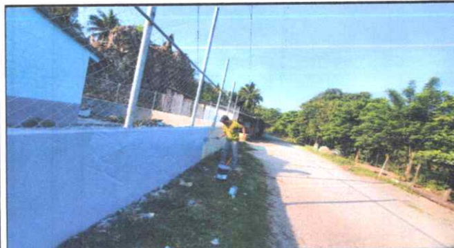
Foto 3: PINTURA DE MURO PERIMETRAL
