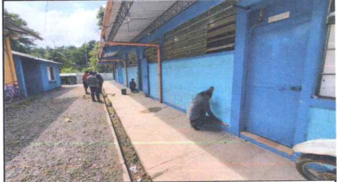
Foto 2: PINTURA PARA AULAS, COCINA Y BAÑOS EN INTERIOR Y EXTERIOR
