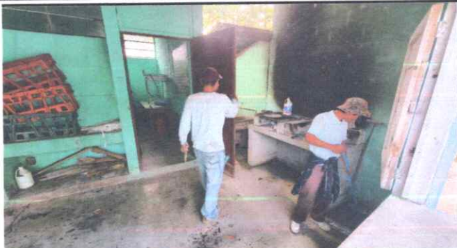
Foto1: SUSTITUCION DE PISO CERAMICO CHIMENEA Y PINTURA
