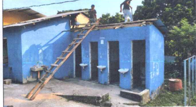
Foto 4: SUSTITUCION DE DRENAJES, AZULEJO, ALIMENTACION DE AGUA TECHADO Y GALERA EN SANITARIOS
