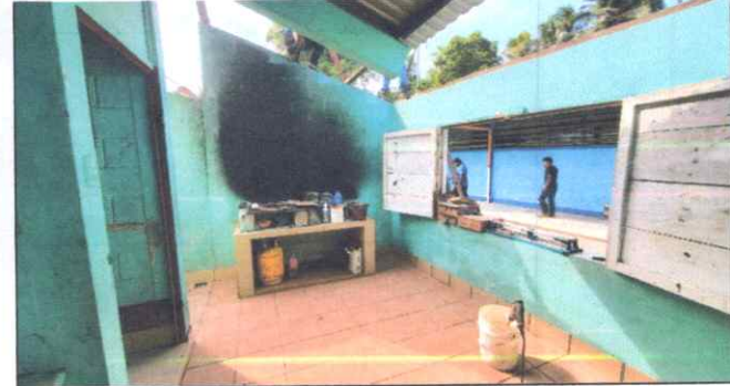
Foto 6: SUSTITUCION DE LAMINA DE LA COCINA
