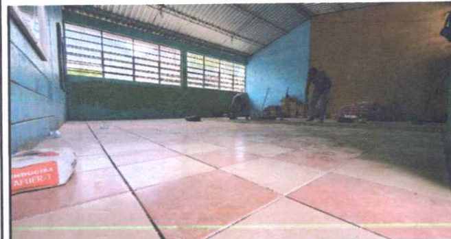
Foto 5: SUSTITUCION DE PISO DE TRES AULAS A PISO CERAMICO
