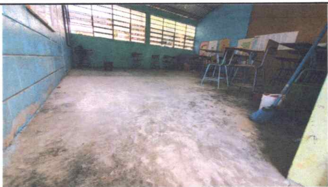
FOTO 5: Sustitución de piso de 3 aulas a piso cerámico.
