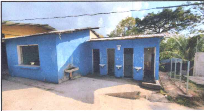
FOTO 4: Sustitución de drenajes, azulejos y alimentación de agua en sanitarios.
