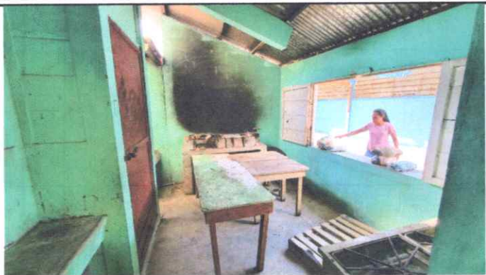
FOTO 1: Sustitución de piso cerámico blanco, chimenea, azulejos.
