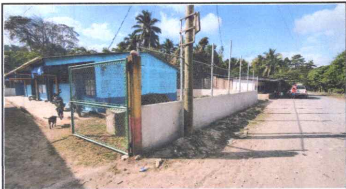
FOTO 3: Pintura de muro perimetral
