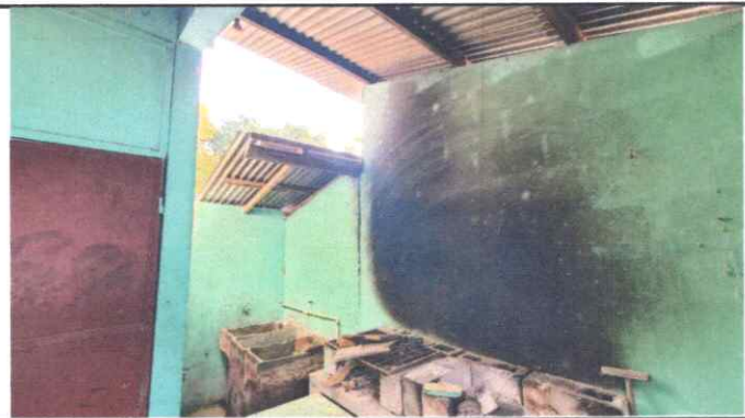
FOTO 6: Sustitución de laminas de la cocina.
