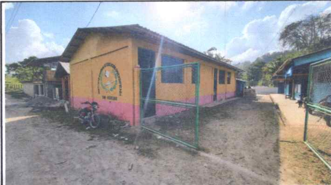
FOTO 2: Pintura para 5 aulas en exterior e interior.
