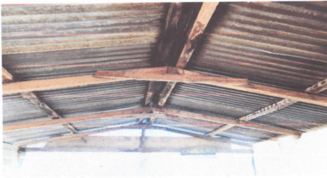
foto 3.sustitucion de estructura de madera, por metal
