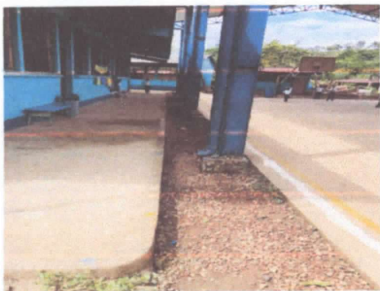
foto 5 sustitucion de piso de concreto por granito
