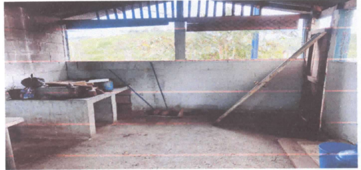
foto 2 sustitucion de piso de concreto por piso de granito
