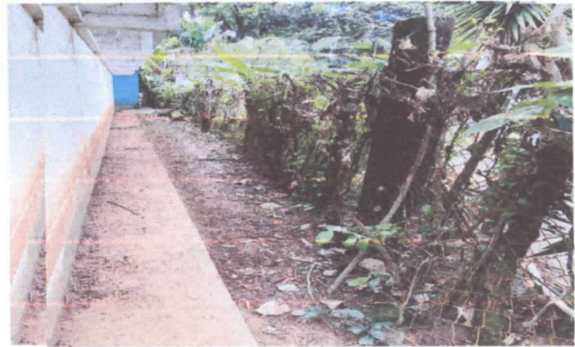
foto 4. construcción de muro perimetral de block.
