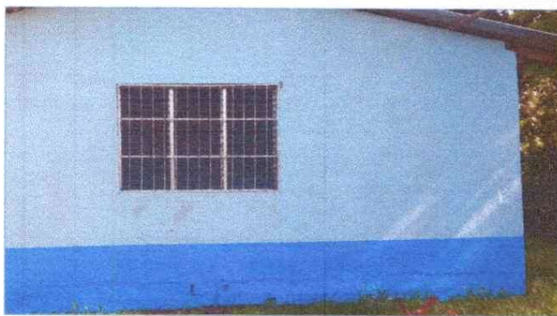
Foto 3: Pintura en muros interiores y exteriores
