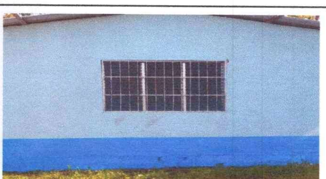
Foto 6: Sustitucion de Balcones
