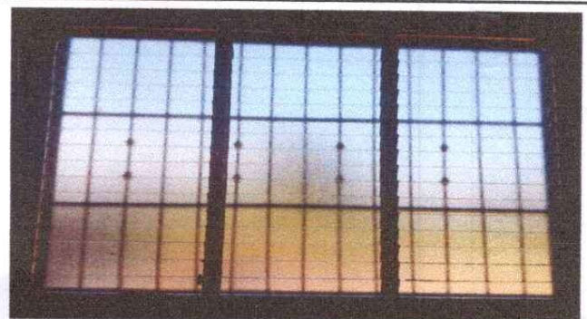
Foto 2: Sustitucion de ventana de madera, por metal mas vidrio
