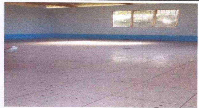
Foto 4: Sustitucion de piso ceramico
