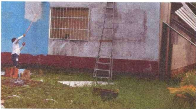
Foto 3: Pintura en muros exteriores e interiores
