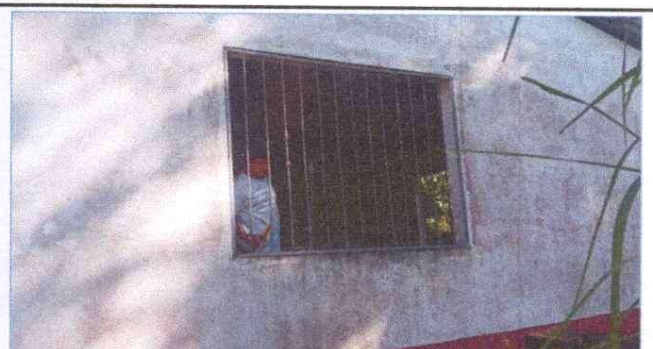
Foto 6: Sustitucion de balcones
