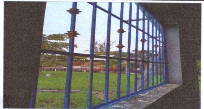
Foto 2: Sustitucion de ventanas de madera, por metal mas vidrio
