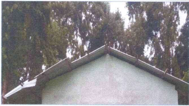
Foto 1: Sustrucion de laminas, por lamina troquelada alucin calibre 26
