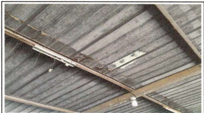
Foto 6: MODULO "A" AULAS SUMINISTRO E INSTALACION DE LAMINA TROQUELADA CAL 26
