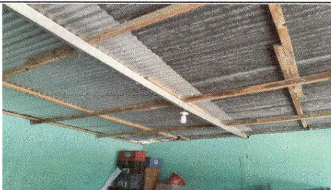
Foto 5: MODULO "A" AULAS SUMINISTRO E INSTALACION DE LAMINA TROQUELADA CAL 26
