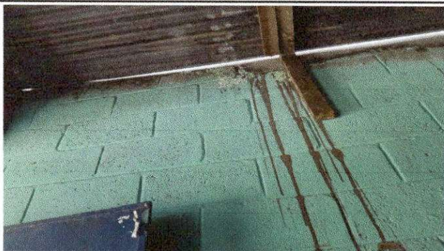
Foto 11: SUMINISTRO E INSTALACION DE LAMINA TROQUELADA CAL 26
