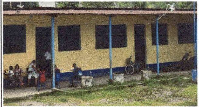
Foto 2: MODULO "A" AULAS REMOZAMIENTO LAMINA Y ESTRUCTURA METALICA
