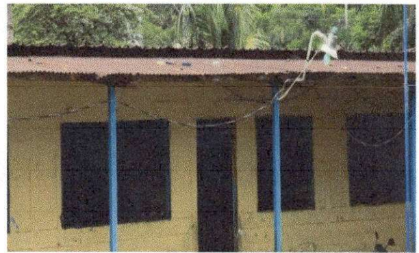
Foto 4: MODULO "A" AULAS REMOZAMIENTO LAMINA
