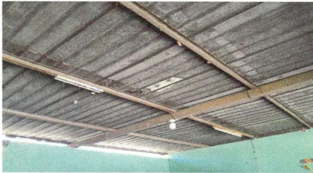
Foto7: SUMINSITRO E INSTALACION DE ESTRUCTURA METALICA
