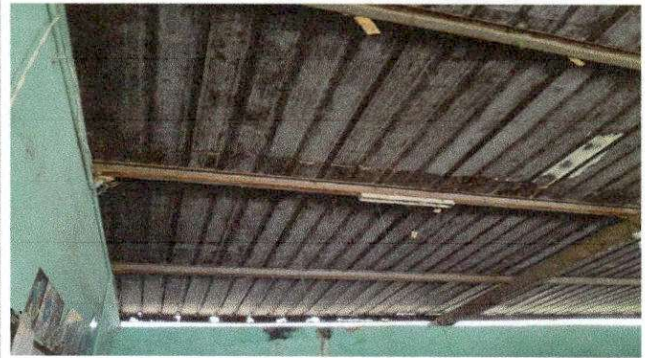
Foto 8 SUMINISTRO E INSTALACION DE LAMINA TROQUELADA CAL 26
