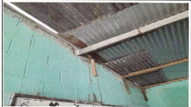
Foto 10 REMOZAMIENTO DE TECHO, SUMINISTRO E INSTALACION DE LAMINA TROQUELADA CAL 26
