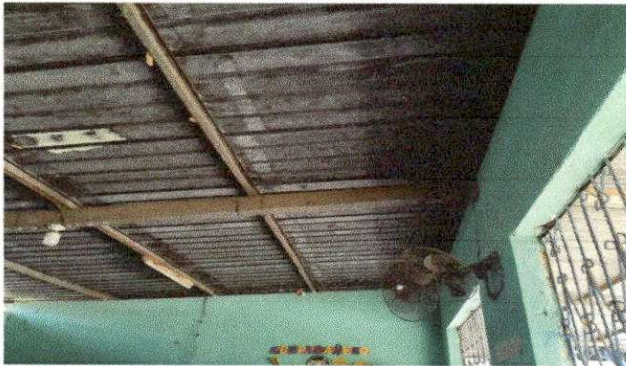
Foto 9: SUMINISTRO E INSTALACION DE LAMINA TROQUELADA CAL 26 SUMINSITRO E INSTALACION DE ESTRUCTURA METALICA
