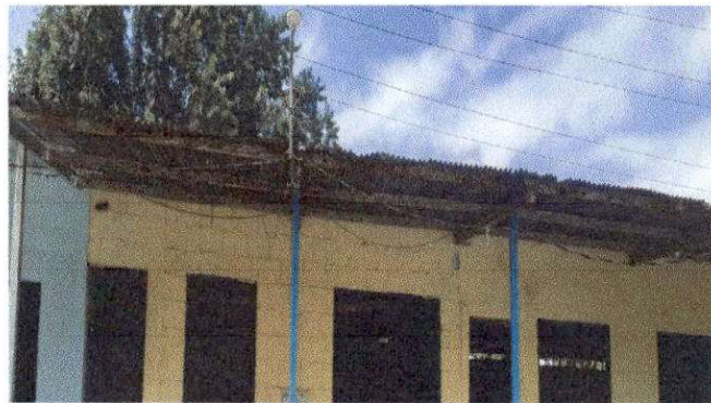
Foto 3: MODULO "A" AULAS REMOZAMIENTO TECHO ESTRUCTURA
