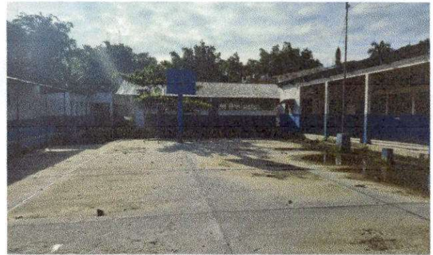
Foto 2: MODULO "A" AULAS
