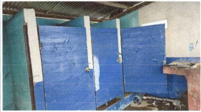
Foto 8: MODULO "B" SERVICIO SANITARIO REMOZAMIENTO DE PUERTAS
