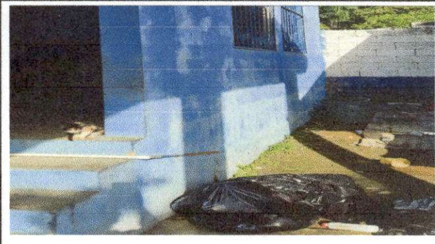
Foto 12: REMOZAMIENTO EN GRADAS
