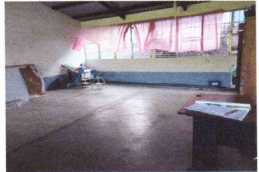
Foto 4. Sustitución de piso cerámico.
