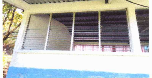
Foto 2. Ventanas sustitución de vidrios.
