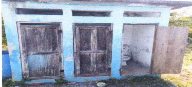
Foto 1. Sustitución de puertas de metal.
