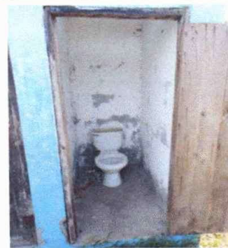
Foto 6. Sustitución de baños.
