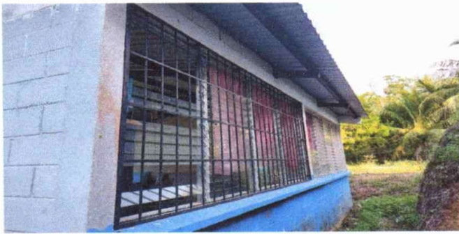
Foto 3. Sustitución de balcones de metal
