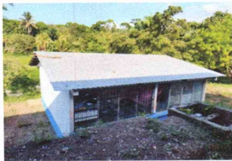
Foto 5. Pintura en muros exteriores e interiores.
