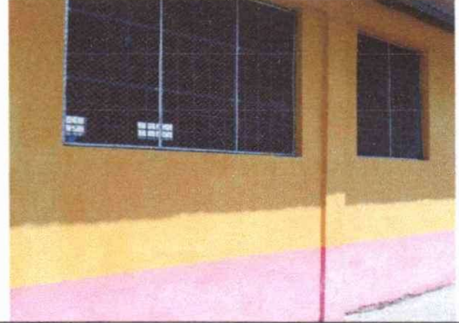
Sustitución de Estructura de Metal de Ventana
