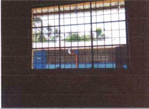
Sustitución de Estructura de Metal de Ventana
