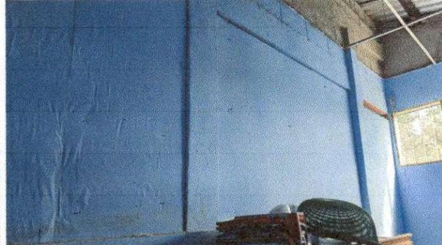
Foto 9: AMPLIACION MURO EN AULA CON REFUERZO ESTRUCTURAL PAREDES CON TABLAYESO SOBREPUESTO
