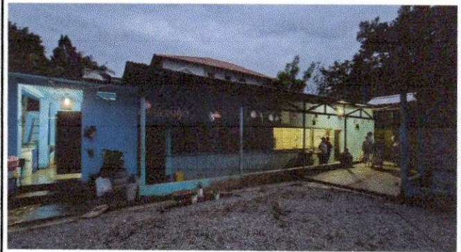
Foto 2: REMOZAMIENTO EN AULAS
