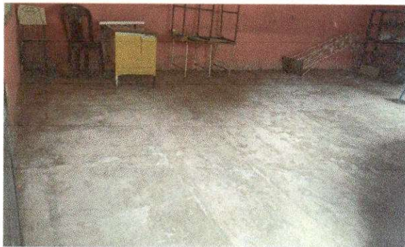
Foto 5: SUMINISTRO E INSTALACION DE PISO CERAMICO ANTIDESLIZANTE
