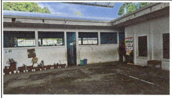
Foto 10: MODULO "B" PASILLO SUMINISTRO E INSTALACION DE PISO CERAMICO ANTIDESLISANTE
