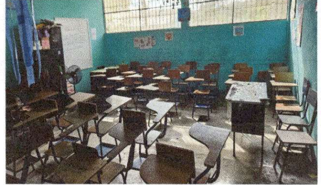
Foto 8: MODULO "A" AULAS SUMINISTRO E INSTALACION DE PISO CERAMICO ANTIDESLISANTE
