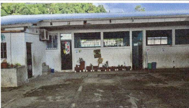
Foto 9: MODULO "B" PASILLO SUMINISTRO E INSTALACION DE PISO CERAMICO ANTIDESLISANTE
