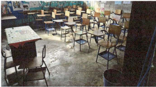
Foto7: MODULO "A" AULAS SUMINISTRO E INSTALACION DE PISO CERAMICO ANTIDESLISANTE
