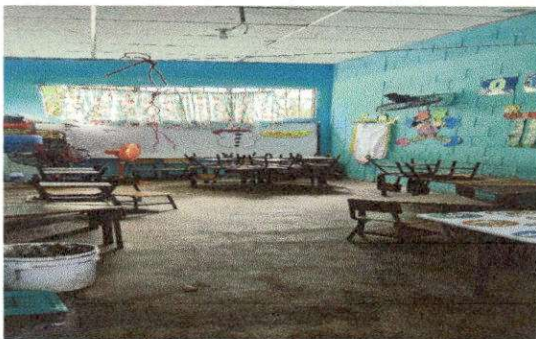
Foto 5: MODULO "A" AULAS SUMINISTRO E INSTALACION DE PISO CERAMICO
