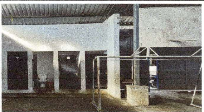
Foto 11: MODULO "B" PASILLO SUMINISTRO E INSTALACION DE PISO CERAMICO ANTIDESLISANTE
