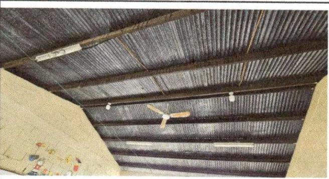
Foto 5: REMOZAMIENTO TECHO SUMINISTRO E INSTALACION DE ESTRUCTURA DE METAL.
