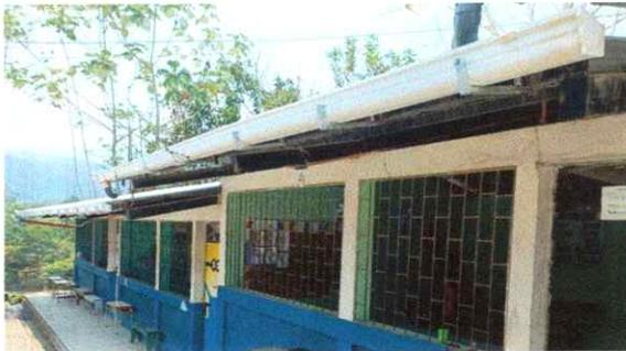
Foto 5: Evidencia de finalización de bases metalicas que sostienen los canales de pvc.
