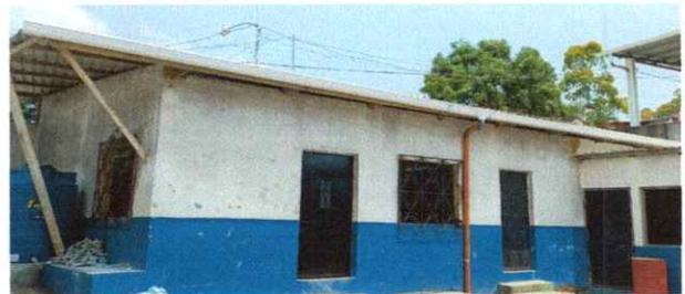
Foto 6: Evidencia de finalización del cambio de canales y caída de agua pluvial.
