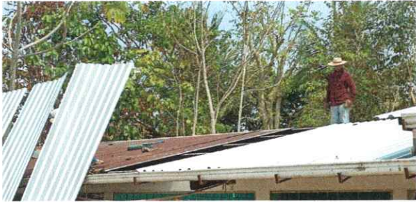
Foto1: Evidencia de sustitución de lamina acanalada a lamina troquelada en un ala de 3 aulas.
