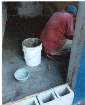
Foto 3: Evidencia de acabado de piso liso en bodega de dirección.
