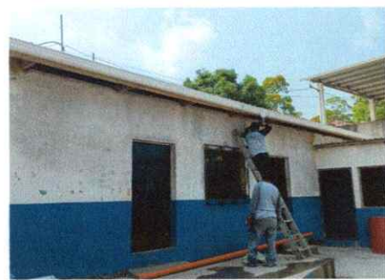
Foto 6: Evidencia de instalacion de canales nuevos y caída de agua pluviales con tubo pvc naranja.
