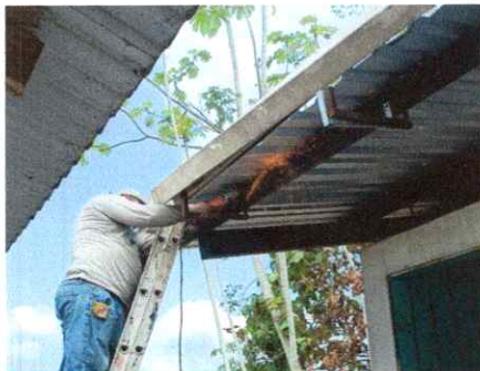
Foto 5: Evidencia de cambio de bases metalicas angulares por bases metalicas de tubo cuadro galvanizado.
