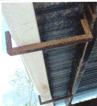
Foto 5: evidencia de bases angulares en mal estado.
