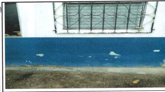
Foto 5: pintura en muros interiores y exteriores
