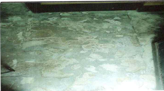
Foto 3: sustitución de piso de concreto para dirección
