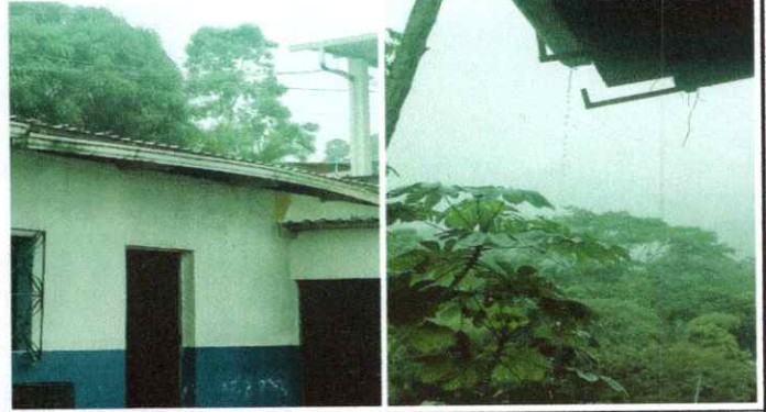
Foto 2: sustitución de canal de pvc y caída de agua pluvial
