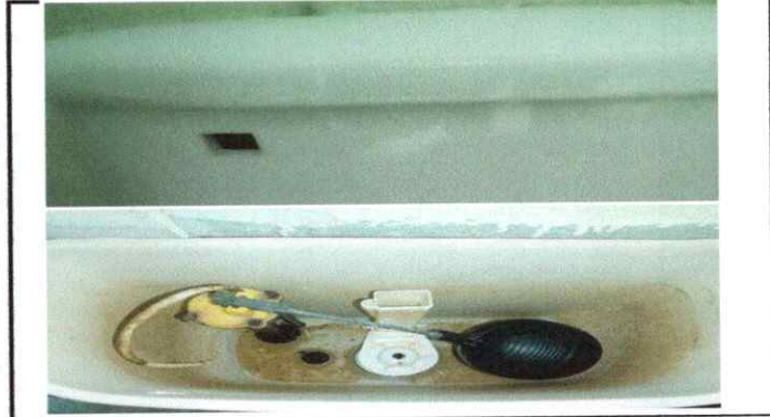
Foto 4: sustitución de accesorios inodoro
