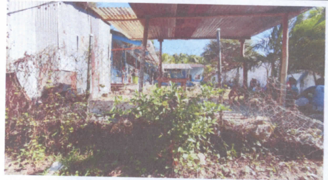
FOTO 4: REPARACION DE MURO PERIMETRAL PARTE FRONTAL
