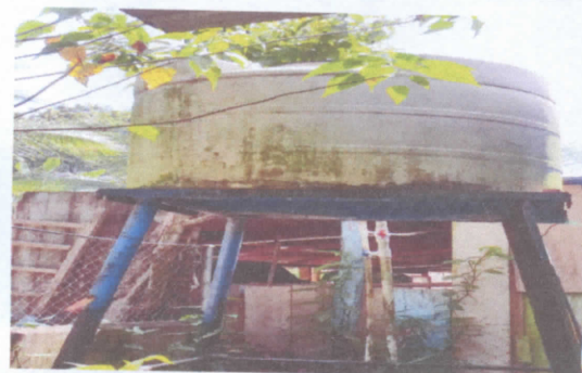
FOTO 6: SUSTITUCION DE ACCESORIOS Y BASE PARA DEPOSITO DE AGUA
