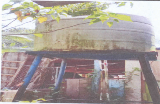
FOTO 5: SUSTITUCION DE DEPOSITO DE AGUA
