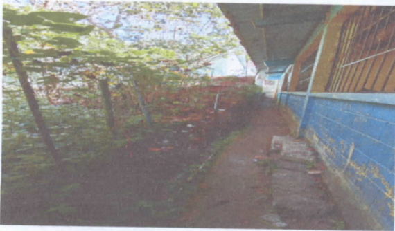
FOTO 3: REPARACION DE MURO PERIMETRAL PARTE DE LADO IZQUERDO
