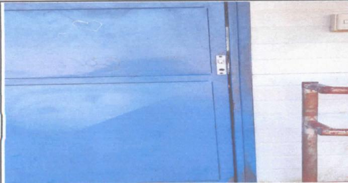
FOTO 1: Sustitución de chapa de metal grande.
