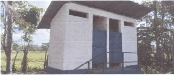
FOTO 1: REPARACIÓN DE BAÑOS
