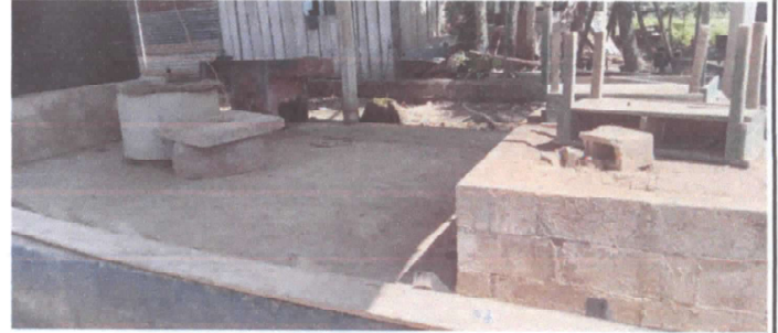
FOTO 2: REPARACIÓN DE COCINA
