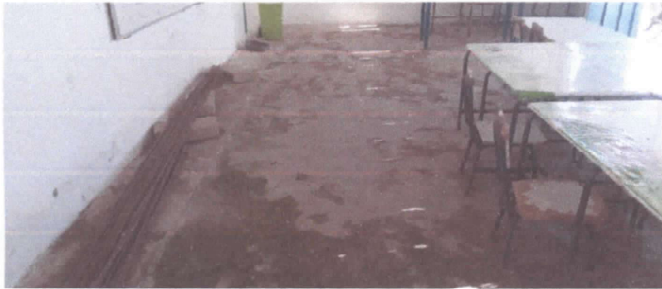
FOTO 3: SUSTITUCION DE PISO GRANITO
