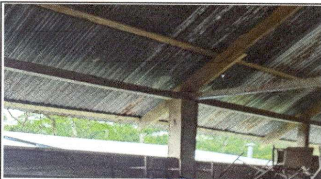
Foto 11: REMOZAMIENTO DE TECHO DE AULA SUMINISTRO E INSTALACION DE ESTRUCTURA METALICA
