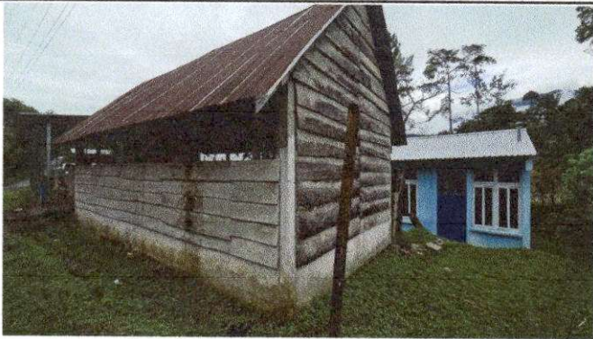
Foto 3: REMOZAMIENTO DE TECHO DE AULA SUMINISTRO E INSTALACION DE ESTRUCTURA METALICA
