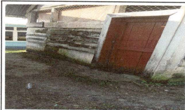
Foto 6: REMOZAMIENTO DE AULA
