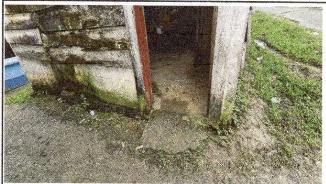
Foto 10: REMOZAMIENTO DE PISO DE AULA SUMINISTRO Y COLOCACION DE PISO CERAMICO ANTIDESLIZANTE
