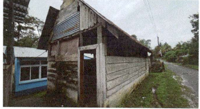
Foto 2: REMOZAMIENTO DE AULA
