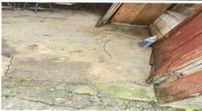
Foto 9: REMOZAMIENTO DE PISO DE AULA SUMINISTRO Y COLOCACION DE PISO CERAMICO ANTIDESLIZANTE
