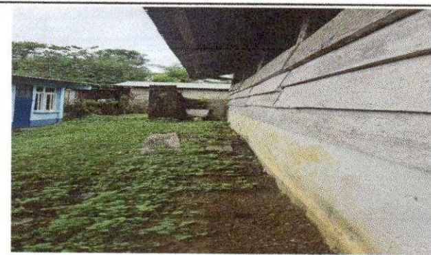
Foto 5: REMOZAMIENTO DE MURO AMPLIACION MURO EN AULA CON REFUERZO ESTRUCTURAL
