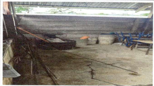
Foto 8: REMOZAMIENTO DE PISO DE AULA
