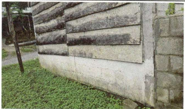
Foto 4: REMOZAMIENTO DE MURO AMPLIACION MURO EN AULA CON REFUERZO ESTRUCTURAL
