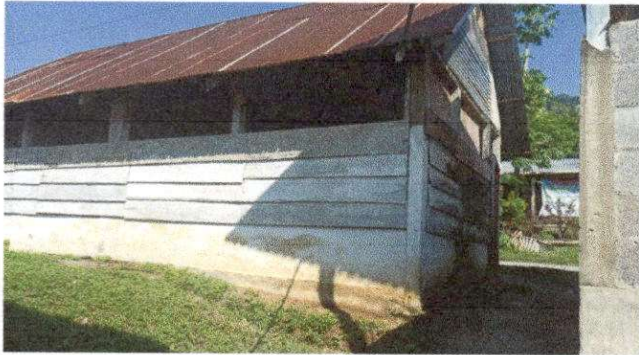
Foto 7: .REMOSAMIENTO DE MURO DE AULA SUMINISTRO E INSTALACION DE ESTRUCTURA METALICA
