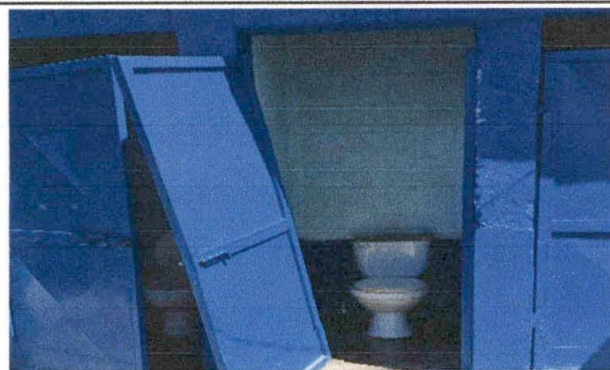
Foto 11: REMOSAMIENTO DE SERVICIO SANITARIO
