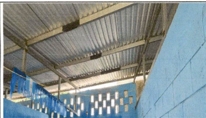
Foto 3: REMOZAMIENTO DE TECHO, COLOCACION DE CIELO FALSO EN AULAS
