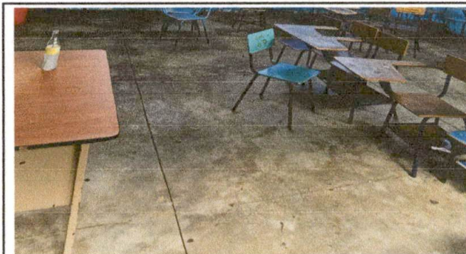
Foto 6: COLOCACION DE PISO EN CENTRO EDUCATIVO PARA REMOZAMIENTO DE AULAS.
