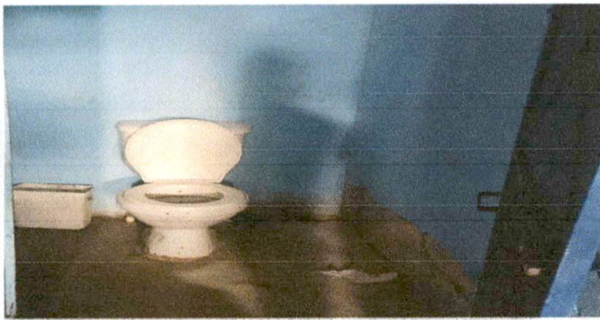
Foto 9: SUMINIISTRO Y COLOCACION DE AZULEJO EN SERVICIO SANITARIO
