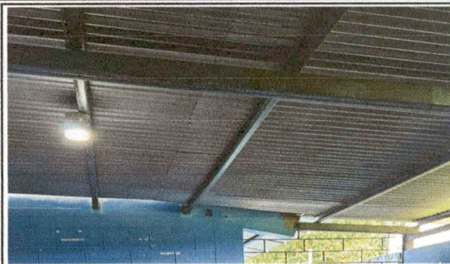
Foto 2: SUMINIISTRO E INSTALACION DE CIELO FALSO EN AULAS DEL CENTRO EDUCATIVO.
