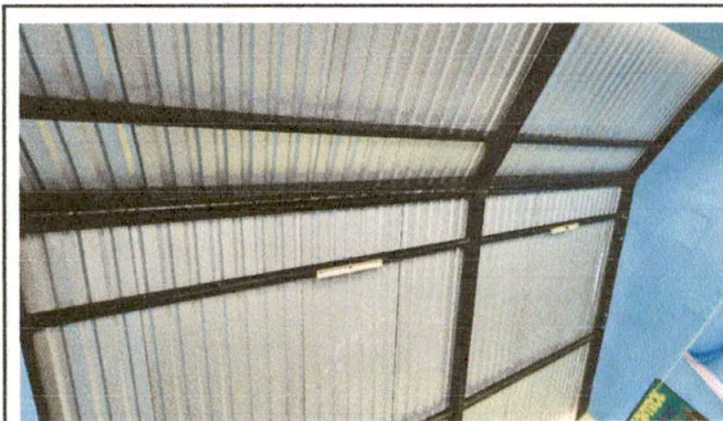
Foto 4: SE COLOCARA CIELO FALSO EN AULAS DEL CENTRO EDUCATIVO.
