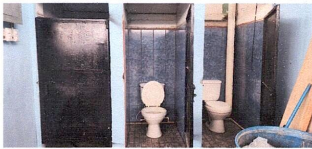
Foto 9: Suministro e instalación de puertas, piso, azulejo e inodoros.
