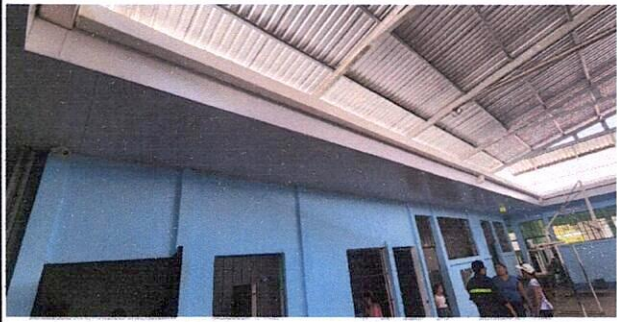
Foto 7: Suministro e instalación de canal
