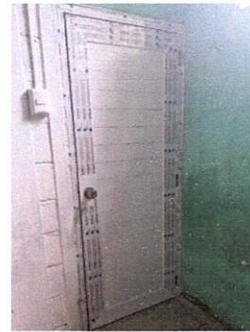
Foto 8: Suministro e instalación de puerta de PVC
