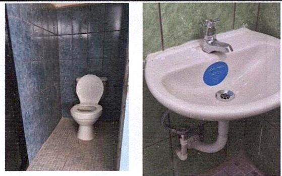
Foto 10: Suministro e instalación de lavamanos e inodoro.
