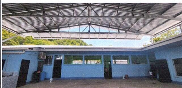
Foto 11: Aplicación de pintura
