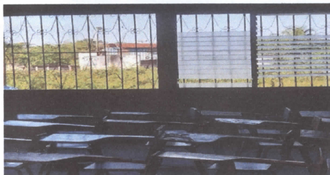
Reparación de balcones y ventanales de diferentes aulas
