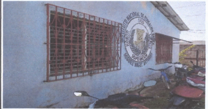
Reparación de Balcones y ventanales de la Direccion
