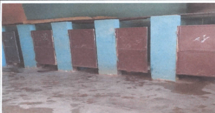
Puertas de baños de mujeres
