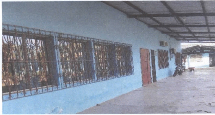
Reparacion de balcones y pintura
