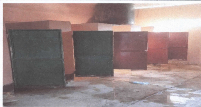
Puertas de baños de hombres
