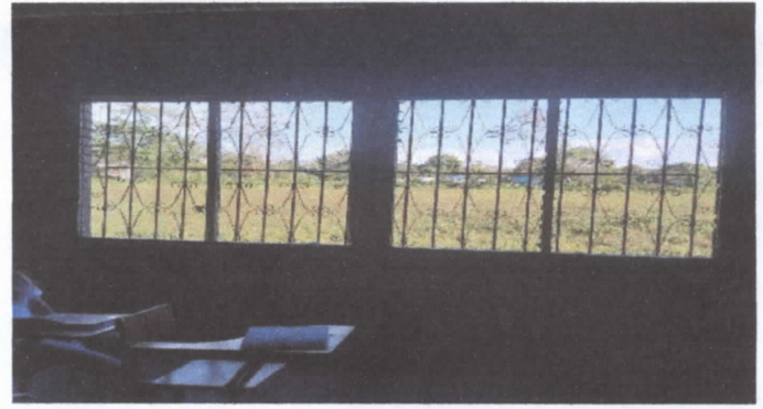
Reparación de balcones y ventanales de diferentes aulas
