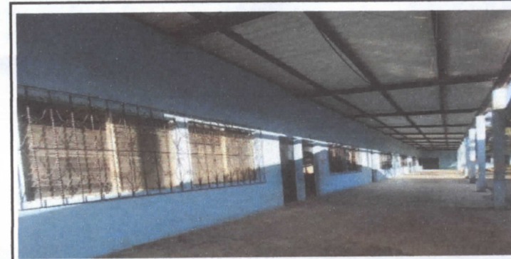
Reparación de balcones y pintura
