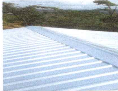
Foto 2: cubierta de lamina del aula de 1ro, 5to y 6to
