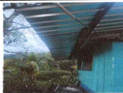
Foto 6: reparacion de cocina techo lamina
