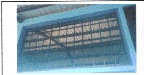
Foto 1: ventanas del aula de 2do, 3ro y 4to
