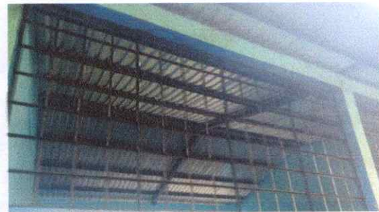
Foto 4: estructura de techo aula de 1ro, 5to y 6to
