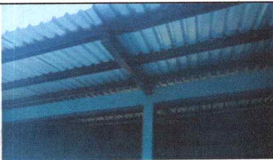
Foto 3: estructura de techo aula de 2do, 3ro y 4to
