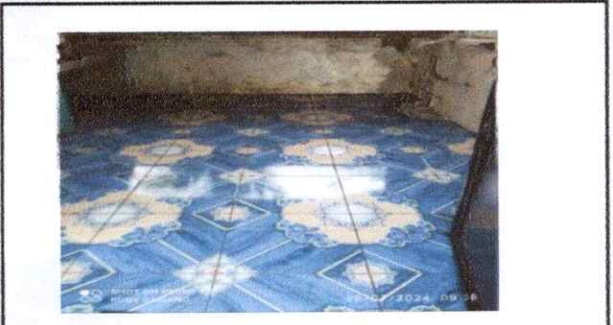
Foto 2: reparacion piso ceramico
