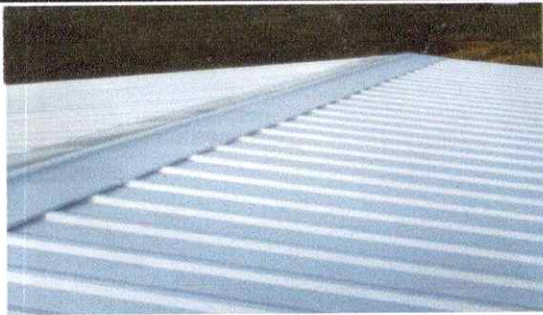
Foto 1: cubierta de lamina del aula de 2do, 3ro y 4to
