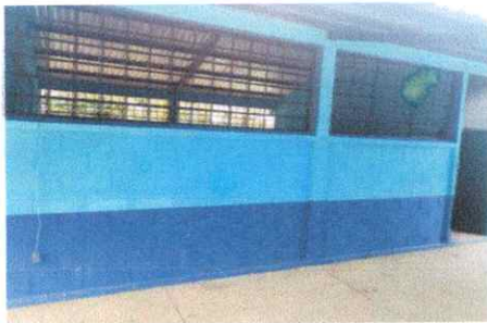
Foto 3: reparacion de sistema electrico aula de 1ro, 5to y 6to
