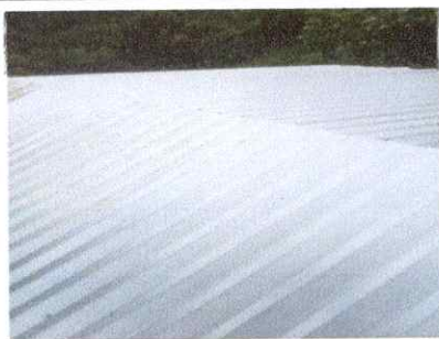
Foto 5: reparacion de cocina techo lamina
