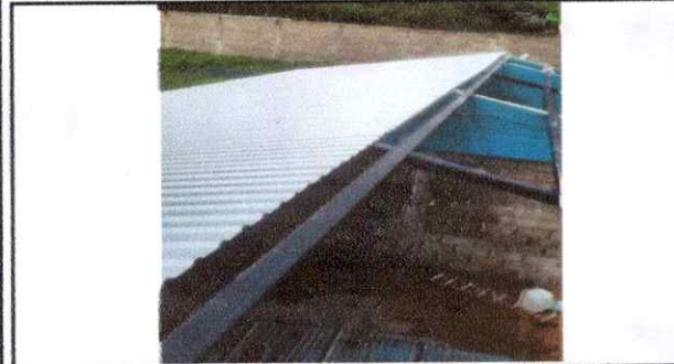
Foto1: cubierta de lamina del aula de 1ro, 5to y 6to primaria
