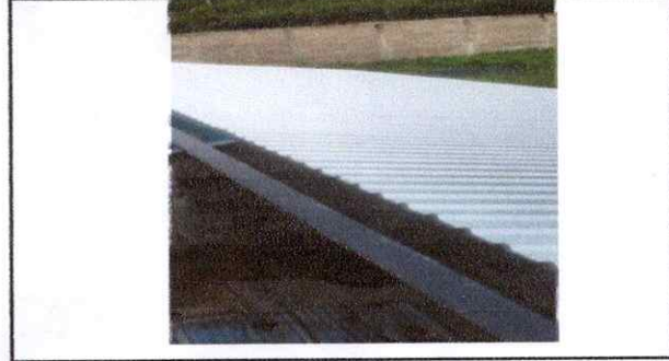
Foto 2: cubierta de lamina del aula de 2do, 3ro y 4to primaria
