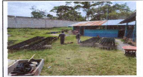
Foto 4: estructura de techo lamina del aula de 1ro 5to y 6to
