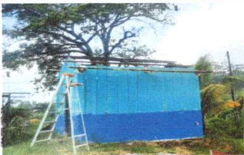
Foto 5: reparacion de cocina techado lamina
