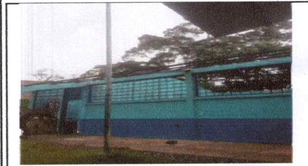
Foto 3: estructura de techo lamina del aula de 2do, 3ro y 4to
