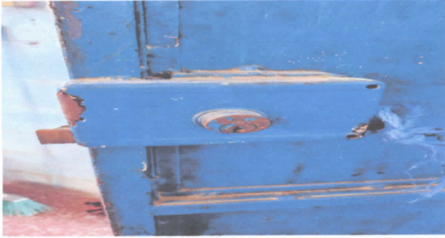
SUSTITUCION DE CHAPA YALE
