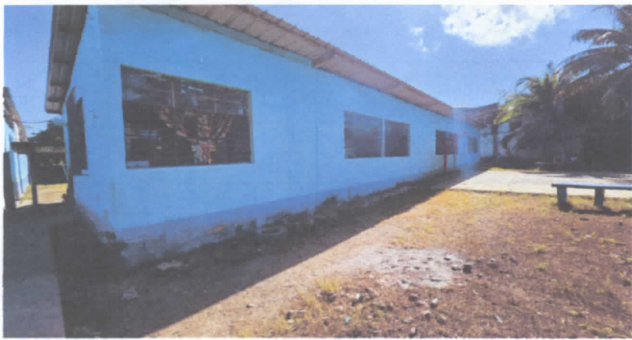
SUSTITUCION DE PINTURA AULAS EXTERIORES
