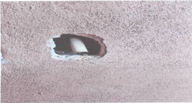
SUSTITUCION DE CABLEADO ELECTRICO
