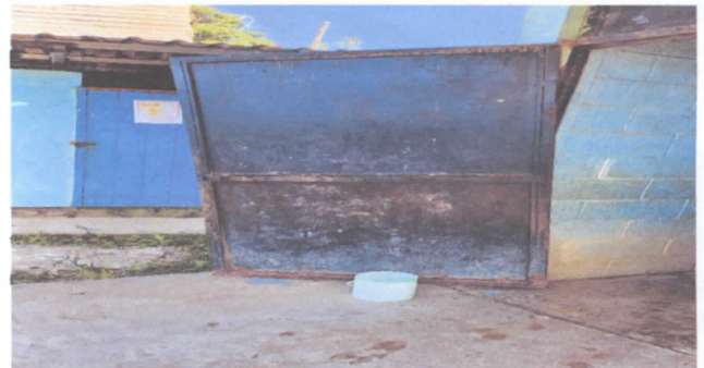
SUSTITUCION DE DOS PUERTAS DE METAL
