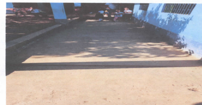
SUSTITUCION DE PISO DE CONCRETO
