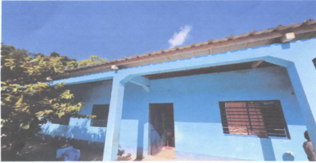
SUSTITUCION DE PINTURA
