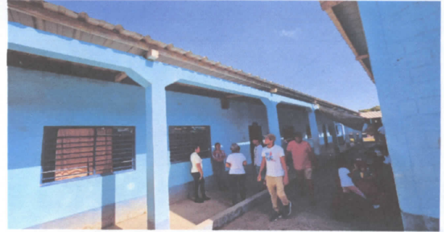
SUSTITUCION DE PINTURA
