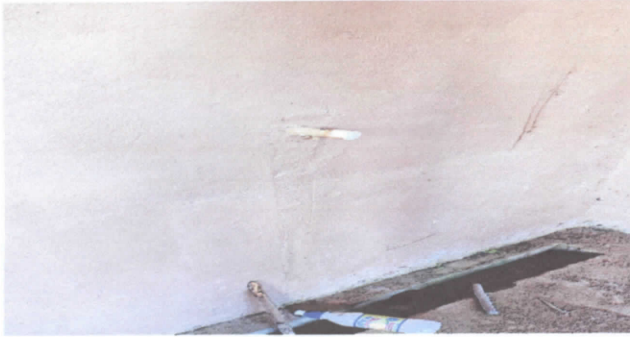
SUSTITUCION DE TUBERIA DE AGUA POTABLE
