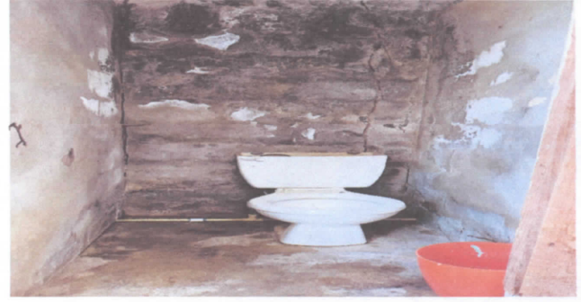
SUSTITUCION DE BAÑOS DE NIÑOS
