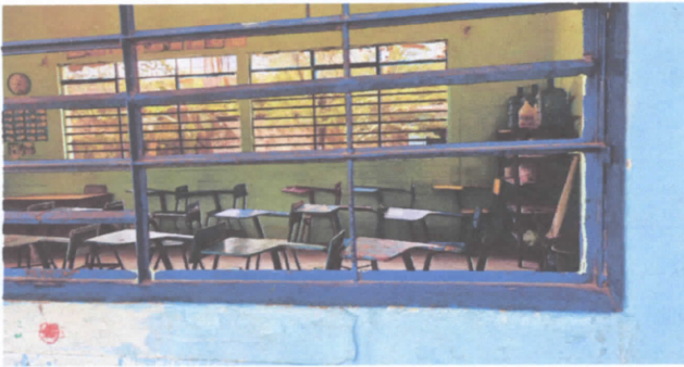
SUSTITUCION DE BALCON
