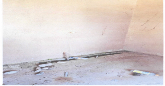
SUSTITUCION DE TUBERIA DE DRENAJE
