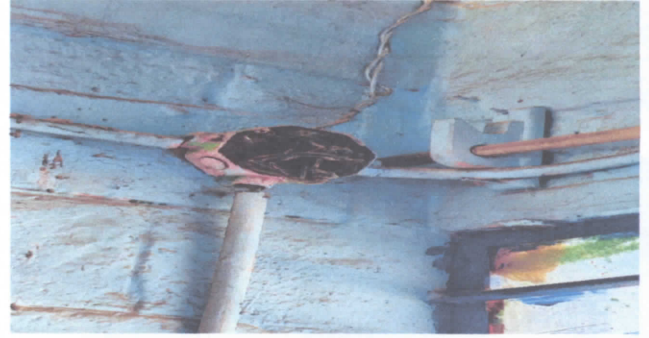
SUSTITUCION DE DUCTO ELECTRICO DE AULAS
