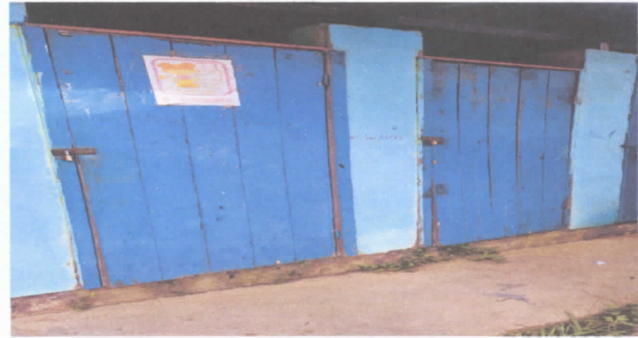
SUSTITUCION DE PUERTAS DE MADERA POR METAL
