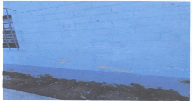
SUSTITUCION DE PINTURA AULAS EXTERIORES
