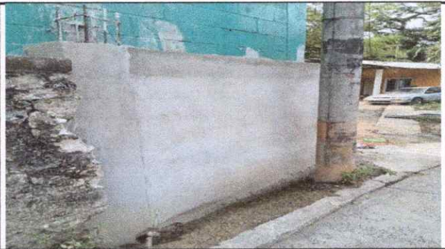
Foto 4: Finalización de la reparación del muro de contención del edificio escolar en el área de la calle principal de la Colonia.
