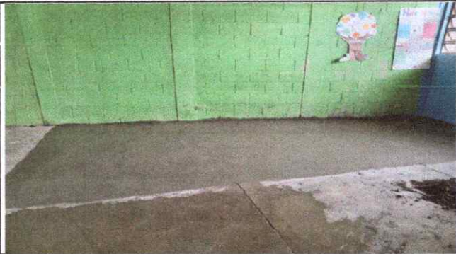
Foto1: Finalización de la reparación del piso que estaba húmedo en el aula No. 3.
