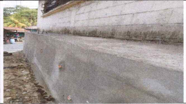
Foto 2: Culminando la parte de arriba del muro de contención y colocación de respiraderos para drenar humedad.
