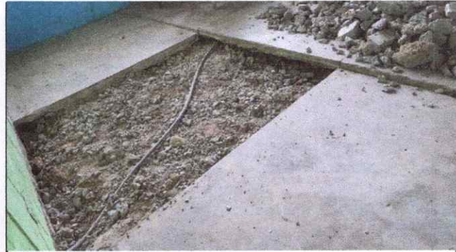
Foto 2: Reparación de piso hundido aula No. 3
