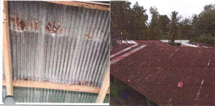
SUSTITUCIÓN DE LÁMINA
