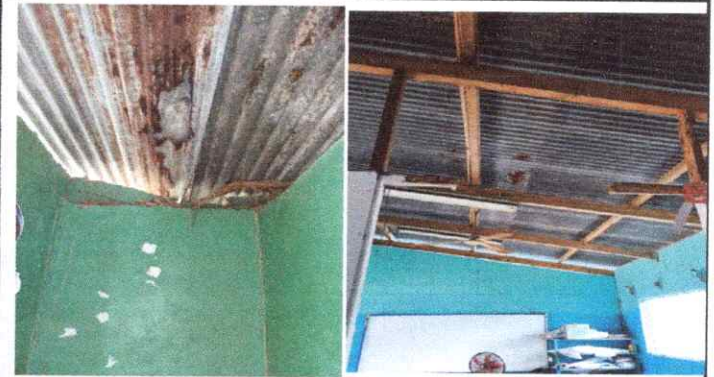
SUSTITUCIÓN DE LÁMINA
