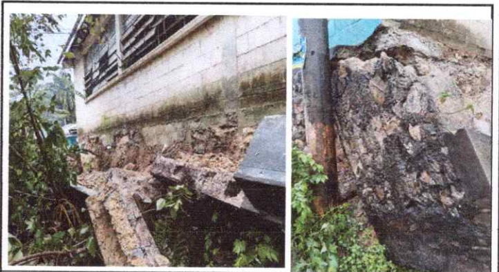
REPARACIÓN DE MURO DE CONTENCIÓN
