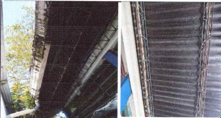
SUSTITUCIÓN DE ESTRUCTURA DE METAL, POR COSTANERA
