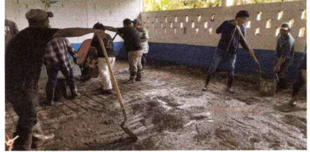
SUSTITUCION DE PISO
