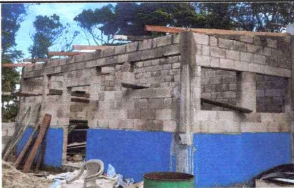
Terminación de Aula
