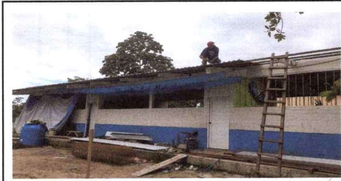
SUSTITUCION DE TECHO
