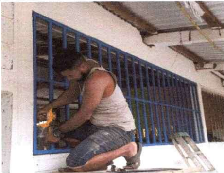
SUSTITUCION DE BALCONES
