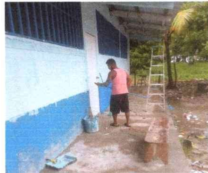
APLICACIÓN DE PINTURA EXTERIOR
