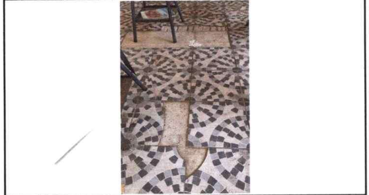
FOTO 2. REPARACIÓN DE PISO CERÁMICO
