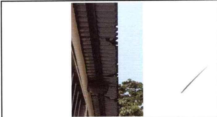
FOTO 1. REPARACIÓN TECHO LAMINADO
