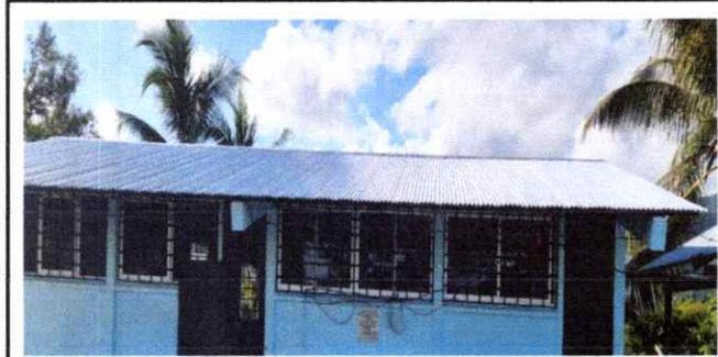
Foto1: SUSTITUCION DE LAMINAS DE DOS AULAS
