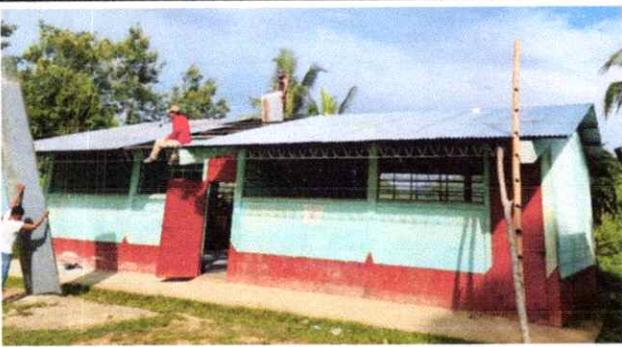
Foto1: SUSTITUCIÓN DE LAMINAS DOS AULAS
