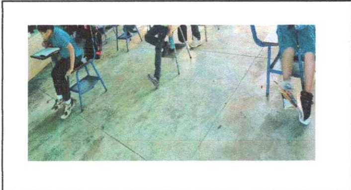
FOTO 3: SUSTITUCIÓN DE PISO CERAMICO
