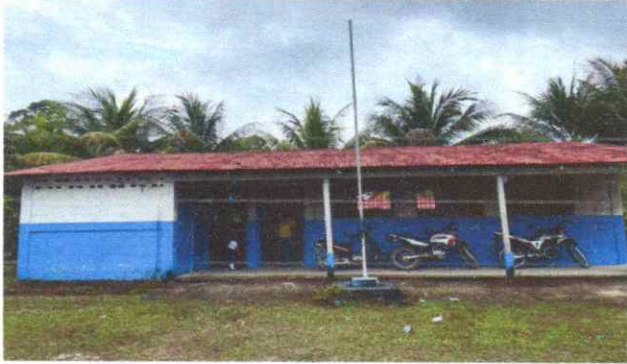
Foto 1: Sustitución de láminas en 3 aulas y cocina
