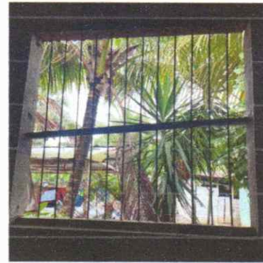
Foto 4: Sustitución de ventanas
