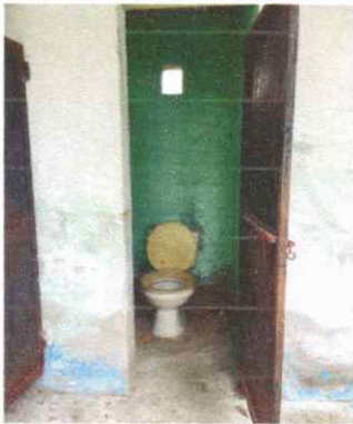
Foto 3: Sustitución de inodoros
