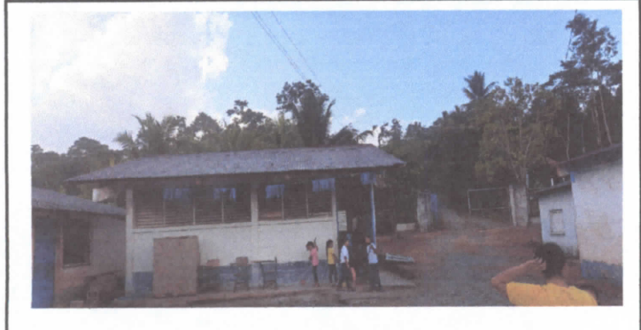
FOTO:1 SUSTITUCIÓN DEL TECHADO DEL AULA DE PRIMERO Y SEGUNDO PRIMARIA
