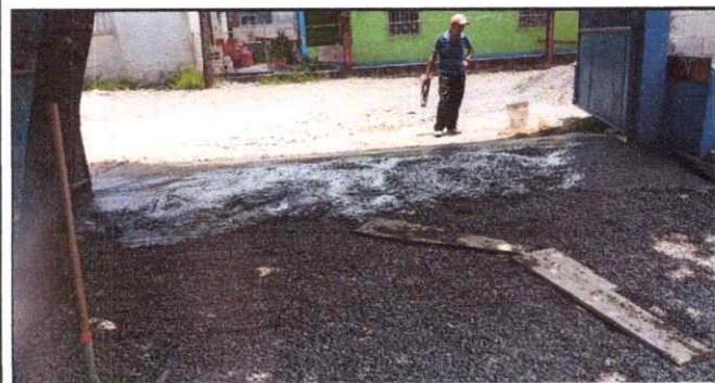
ELABORACION DE RAMPA Y REPARACION DE VIGAS
