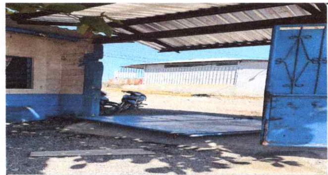
MANTENIMIENTO DE PORTON, PINTURA DE COSTANERAS
