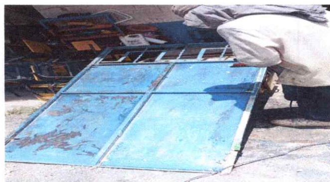
MANTENIMIENTO DE PUERTAS
