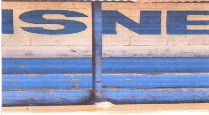
Parales de la galera de las gradas
