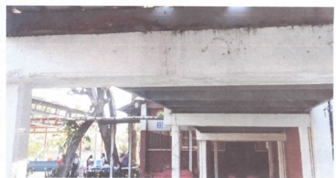
Foto No. 4 Techo de Pasillo de Área de Comedor
