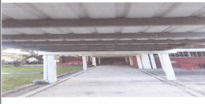
Foto No. 3 Techo de Pasillo de Área de Metales
