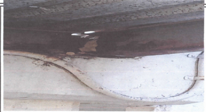
Foto No. 2 Techo de Pasillo de Librería
