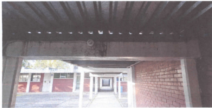
Foto No. 1 : Techo del sector de la Entrada
