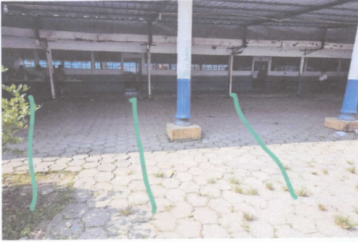
Foto1: Corte de piso y fundición para introducir bajada de agua pluvial
