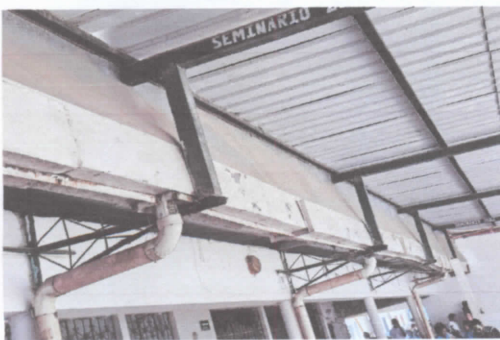
Foto5: Sustitución de canal
