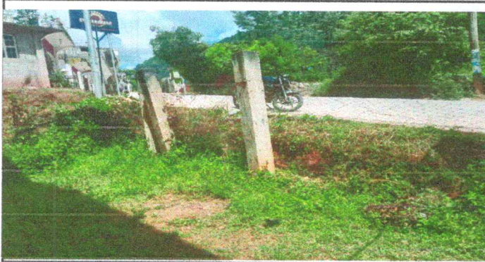
Foto 1: Reparación del muro o tapial
