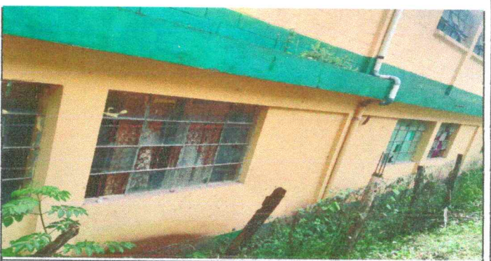
Foto 6: Sustitución de vidrios y colocación de balcones.
