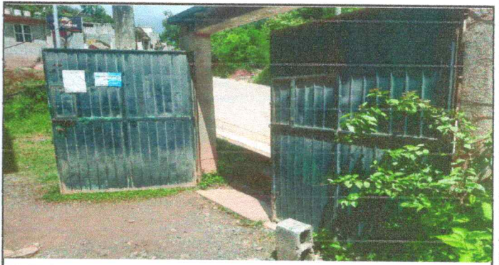
Foto 4: Sustitución de portón.
