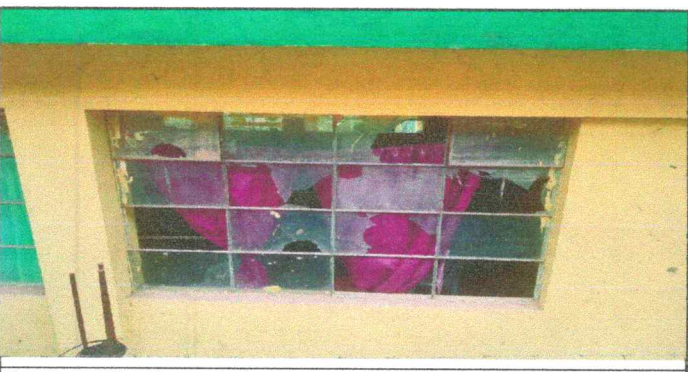
Foto 5: Sustitución de vidrios y colocación de balcones.
