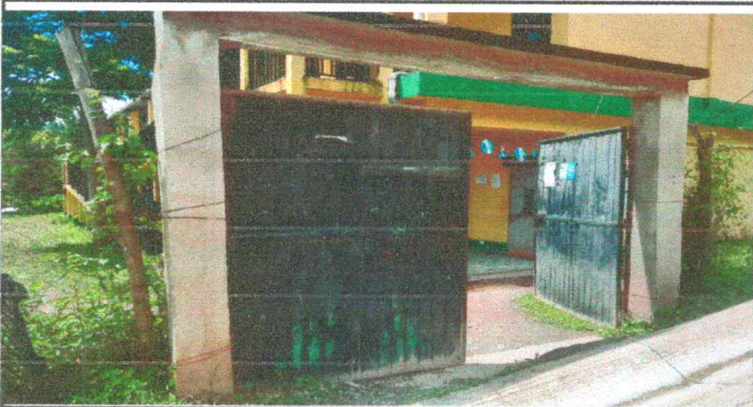
Foto 3: Sustitución de portón.
