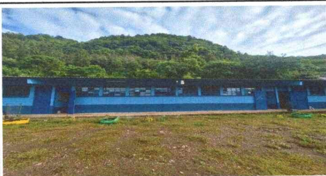
Foto 3: Pintura en muros exteriores e interiores
