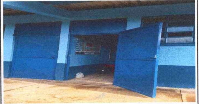
Foto 2: Puertas en buen estado
