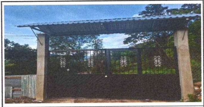
Foto 6: Sustitución de portón
