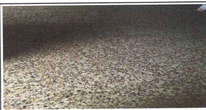
Foto 5: Sustitución de piso por piso de granito
