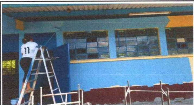
Foto 3: Pintura en muros exteriores e interiores
