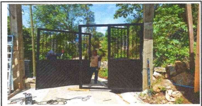
Foto 6: Sustitución de portón
