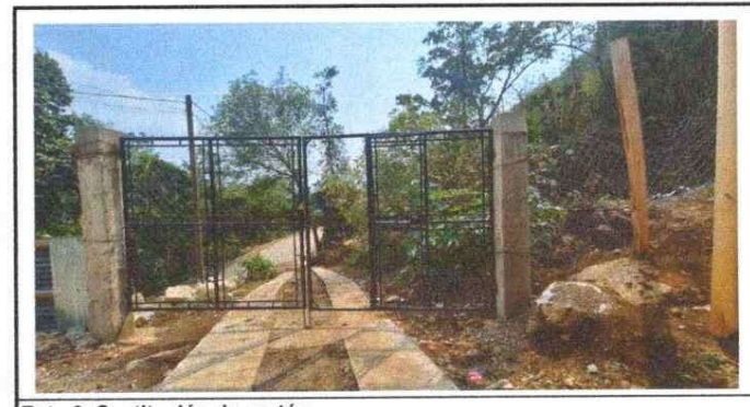
Foto 6: Sustitución de portón
