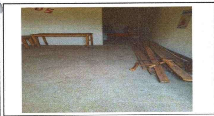
Foto 5: Sustitución de piso por piso de granito
