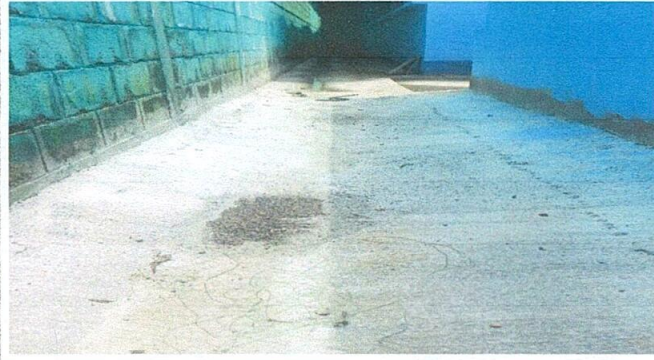
Foto 1: REPARACIÓN DE CUNETA DE CONCRETO
