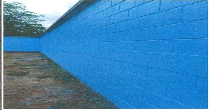
Foto 2: REPARACIÓN DE MURO PERIMETRAL DE BLOCK
