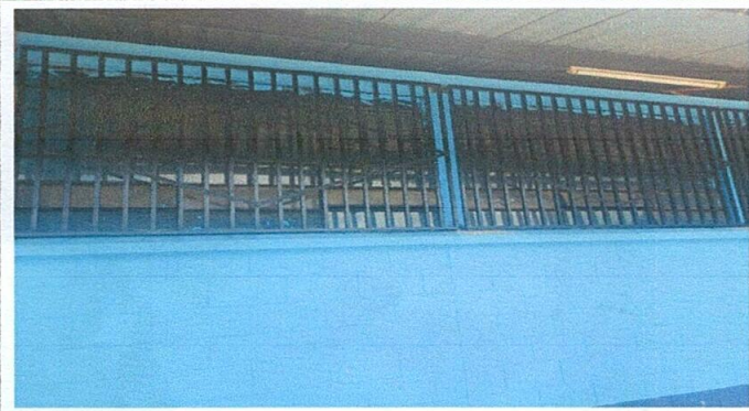
Foto 3: SUSTITUCIÓN DE BALCONES DE METAL
