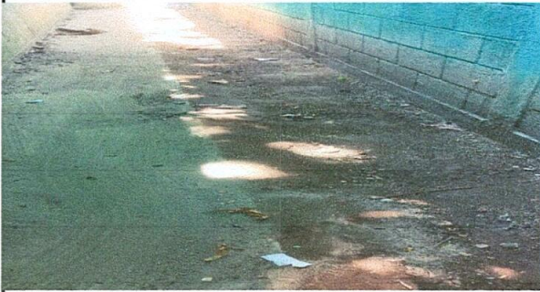
Foto 1: REPARACIÓN DE CUNETA DE CONCRETO
