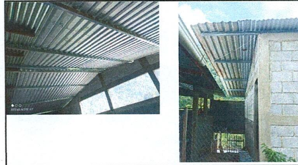
Foto 2: Sustitución de lámina, por lámina ondulada normal calibre 26
