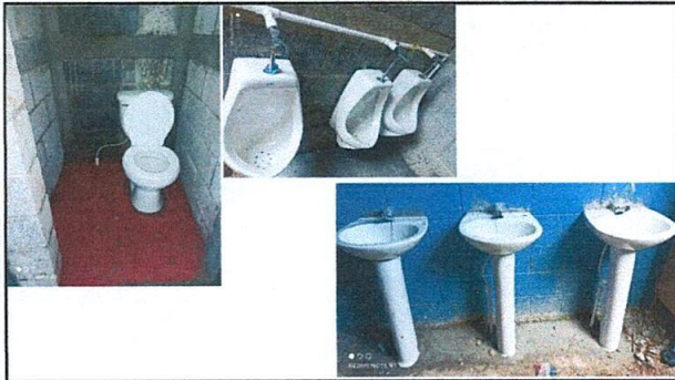
Foto7: Mejoramiento de baños, mingitorios y lavamanos
