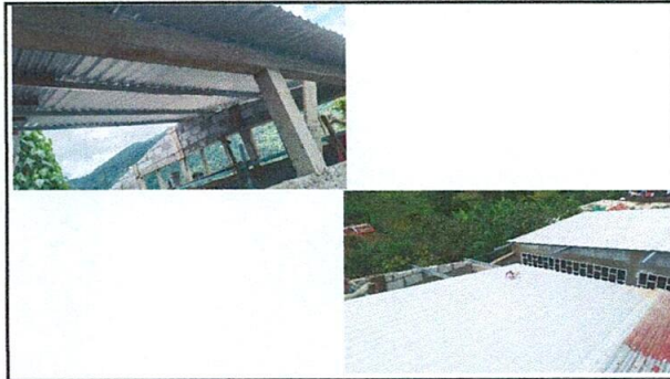
Foto 2: Sustitución de lámina, por lámina ondulada normal calibre 26
