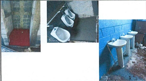
Foto7: Mejoramiento de baños, mingitorios y lavamanos
