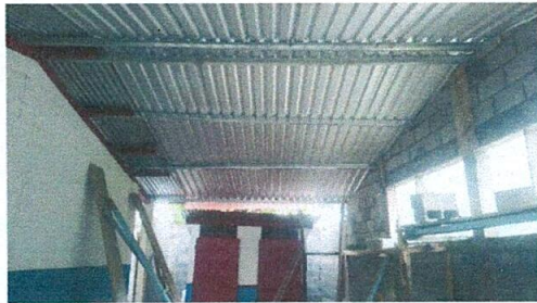
Foto 3: Sustitución de estructura de soporte de madera, por metal
